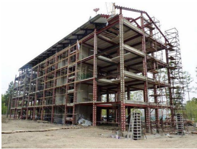
ЦЭМП, г. Железнодорожск Поставка воздуховодов и оборудования. 2015 г.
