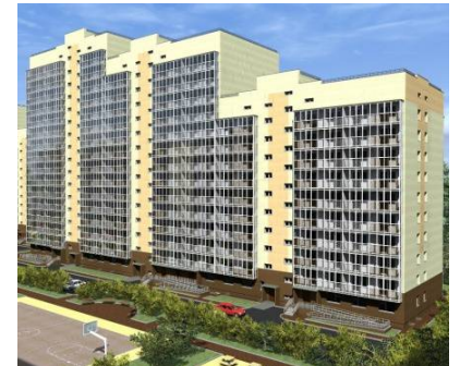
ЖК «Нанжунь-Солнечный» Поставка воздуховодов и оборудования. 2015 г.
