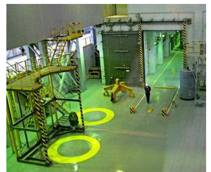
Объекты ФГУП «ГХК». Вентиляция «под ключ». 2015 г.
